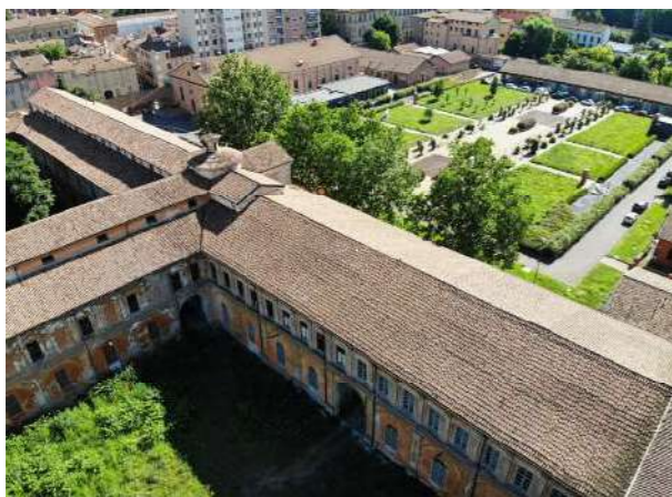
Stecca est dell'Archivio di Stato dall'alto: lato verso i cortili.
